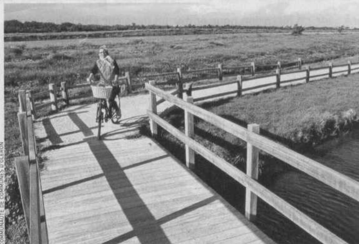
Aujourd'hui, 108 kilomètres de voies cyclables maillent Oléron, contribuant au désengorgement des axes routiers et à l'amélioration de la sécurité.
